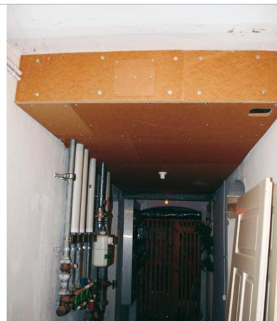
Die solide Kellerdeckenisolierung dämmt die Erdgeschosswohnung.
